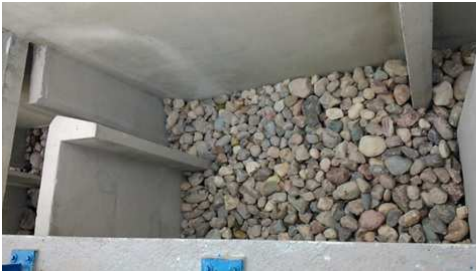
Fot. 2. Przepławka we Włocławku po modernizacji w 2014 r.
