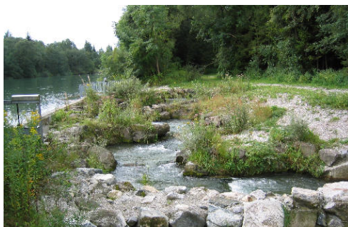
Fot. 5. Przepławka na rzece Isar w Bawarii/Niemcy Źródło: K. Czołch
