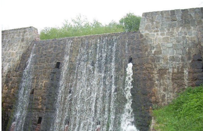
Fot. 4. Zapora przeciwrumowiskowa na pot. Łopaczyńskim, Wysowa Zdrój, woj. małopolskie Źródło: K. Czołch
