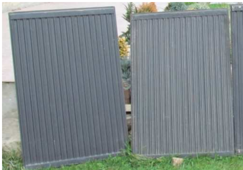
Fot. 1. Grzejniki panelowe używane do budowy kolektora słonecznego
