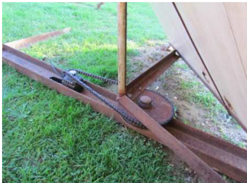
Fot. 4. System solar track zamontowany na stojaku do kolektora słonecznego Źródło: fot. M. Dyląg
